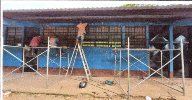
Foto 2: Realizando mantenimiento de techo
