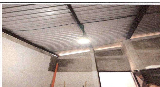
Foto 4: Instalando cables electricos
