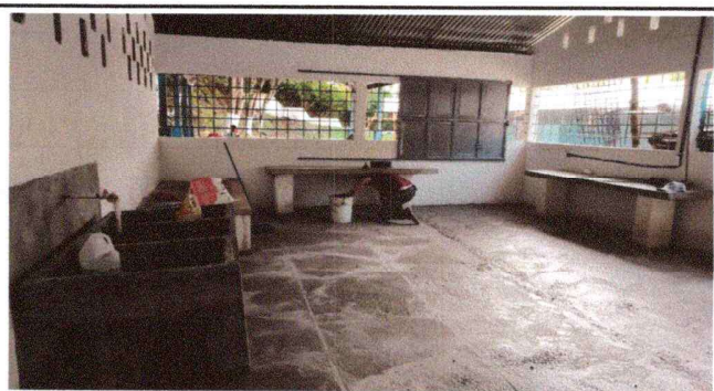
Foto 5: instalando piso de torta de concreto de la cocina
